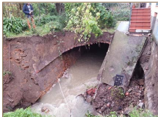
La Spezia, 24/10/2013. Sprofondamento della carreggiata in Loc. Pegazzano (a sinistra, foto: Archivio Cds); collasso della volta per sovrappressione del Canale Cantarana in Loc. Chiappa (a destra, foto: T.D.L).
